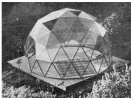
כיפה גיאודסית בנויה ממשטחים מישוריים, המוזלים את העלויות תוך שימור יציבות וחוזק המבנה
